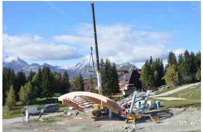
Le toit, en bois lamellé-collé, pèse douze tonnes. Photo Le DL/Vincent ZAVARONI
