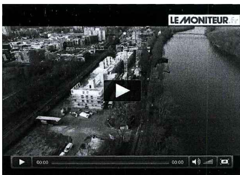
Présentation du chantier du plus grand bâtiment résidentiel en bois massif CLT d Europe à Ris Orangis (91)
