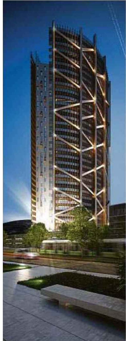
A Nice, l'architecte Jean-Michel Wilmotte travaille sur une tour mixant bois et béton, d'une hauteur de 115 mètres pour 35 étages. Photo Wilmotte & Associés
