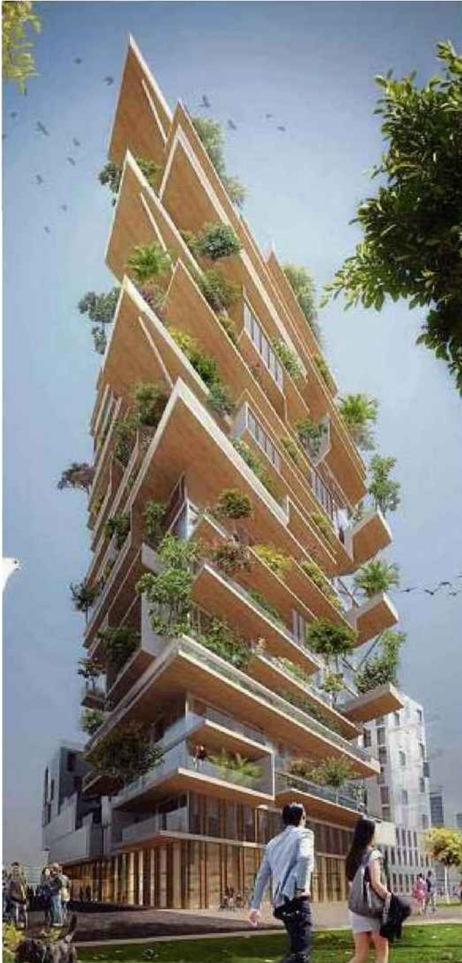
La tour Hypérion, à Bordeaux, devrait être livrée en 2020. Elle se compose aux deux tiers de bois français et d'un tiers de béton. Photo Jean-Paul Viguier & Associés
