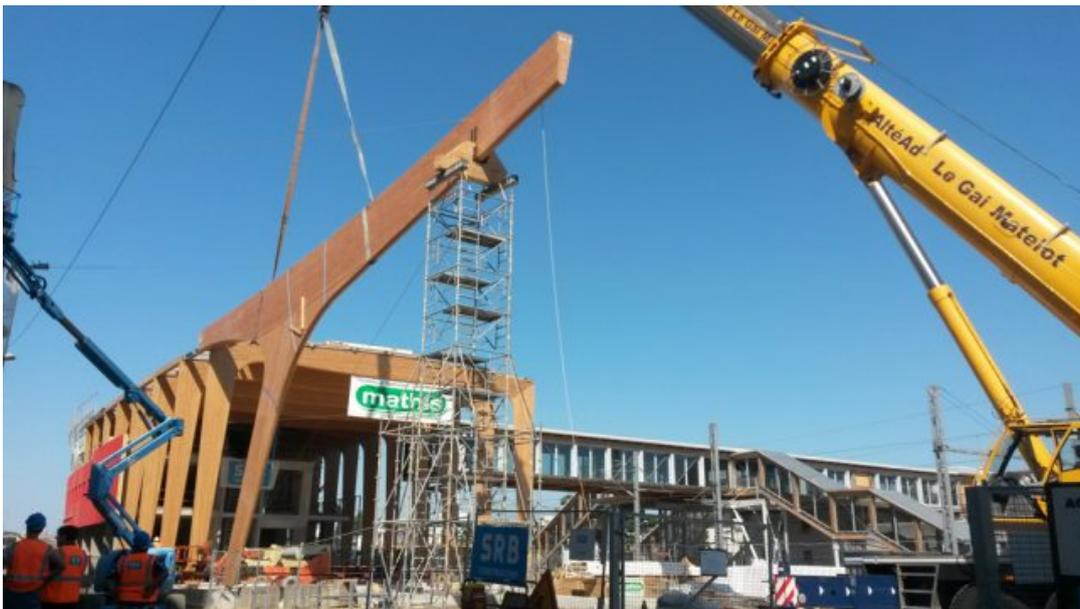
© Jean-Philippe Defawe - La structure du bâtiment voyageur est composée d'une série de semi-portiques, et de portiques en lamellé-collé. Le soutènement d'un vaste auvent sera assuré en rive par une poutre disposée en porte-à-faux qui a été posée avec succès mardi 19 juillet.
