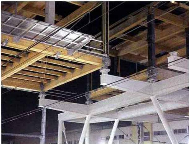
▲ Mise en place de la passerelle sur ses appuis
