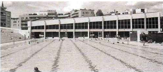
▲ Vue de la halle en béton existante depuis le bassin de 50 m, initialement à ciel ouvert.
