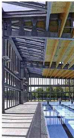
▲ Côté plage, une façade métallique comporte de larges boîtes qui s'ouvrent en partie basse.
