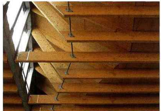
▲ Les pannes-arbalétriers en suspension laissent davantage passer la lumière naturelle.
