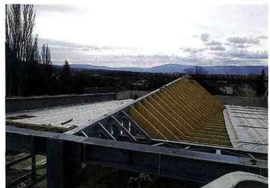
▲ Les pannes-arbalétriers sont recouvertes de panneaux de lamibois.
