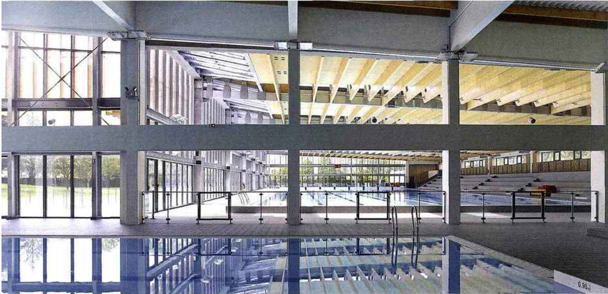
▲ Les trames et les dimensions de la nouvelle halle de bois et d'acier ont été calculées sur celles du bâtiment de béton existant.
