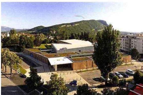
▲ Les cinq sheds de la nouvelle couverture s'inscrivent dans l'orientation du Mont Salève, qui marque le début du massif des Alpes.
