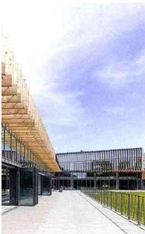
▲ À 5 m du sol, les lames des brise-soleil habillent la partie haute des façades du projet.
