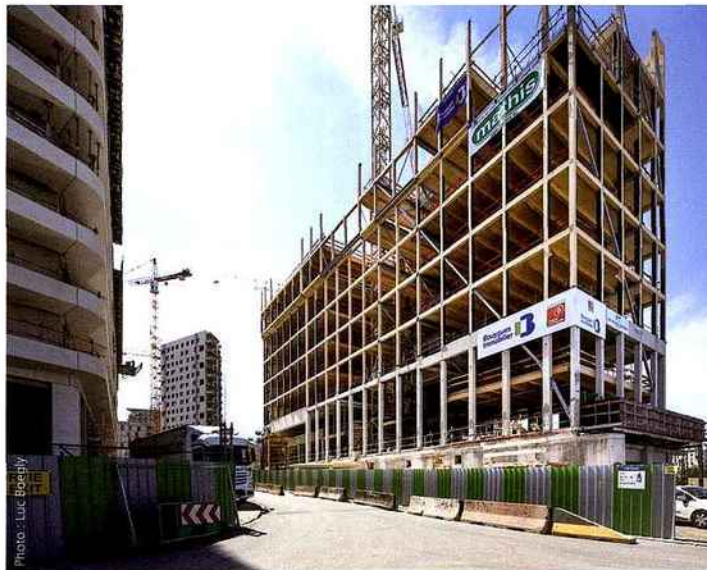
↑ Le contreventement est assuré grâce à des tirants métalliques (tubes de 160 mm au carré remplis de béton) principalement sur les pointes des façades.
