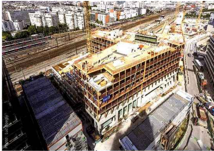
↑ Dans la partie structure bois, il a fallu environ 16 jours pour la réalisation de chacun des étages de 2400 m 2 .
