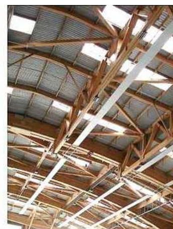
La voûte du hangar avec de nombreuses poutres en bois.
