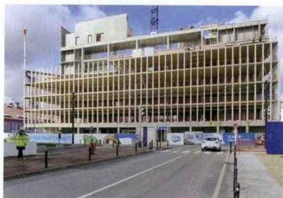
↑ Montage de la superstructure bois.
