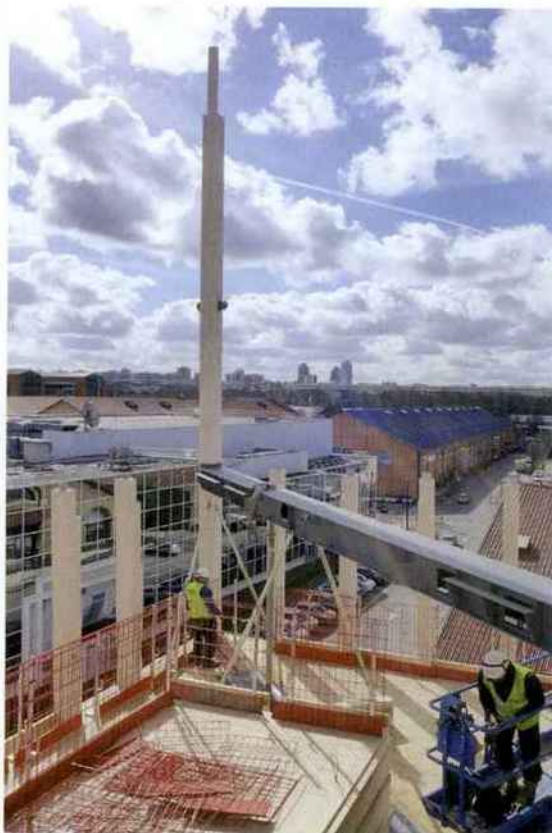
↑ Mise en place d'un poteau d'angle.
