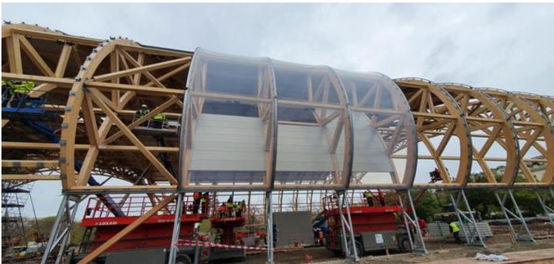
*La partie basse des façades sera revêtue d'une peau en ETFE transparente, de manière à donner à voir les structures bois des portiques. La partie supérieure de la peau sera en toile PVC grise opaque. ©PP
