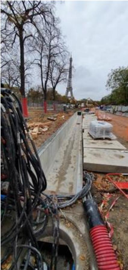
*La production de chaleur, d'eau glacée et le TGBT du bâtiment seront installés dans un bâtiment annexe, à une cinquantaine de mètres du bâtiment principal. Deux caniveaux techniques ont été installés pour amener les réseaux jusqu'au bâtiment principal. Comme ils passent à travers des bosquets d'arbres, leurs tranchées n'ont pas été creusées à la pelleuse, mais « à l'aspirateur » pour n'endommager aucun arbre. ©PP*
