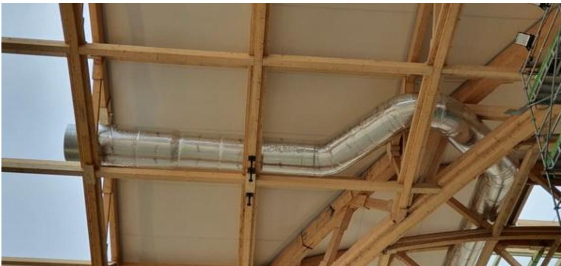
*Les réseaux de distribution d'air chemineront dans le plénum entre la peau extérieure et le revêtement intérieur. ©PP*
