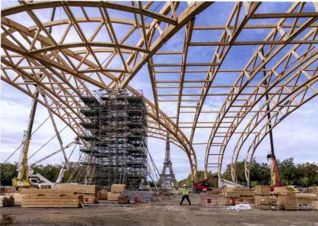
← Le levage a commencé début septembre avec la mise en place des deux grands portiques diagonaux de 65 m de portée qui assurent la clé de voûte au croisement des deux nefs. Pour sécuriser l'assemblage de ces deux arcs, l'entreprise Mathis a installé une tour d'étaie provisoire.
