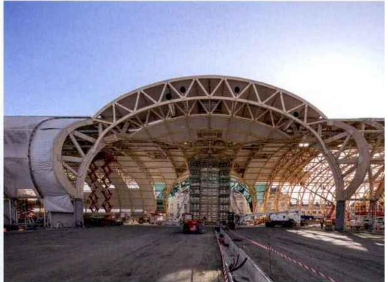
↑ À l'extérieur, la partie supérieure de la coque est protégée par une membrane en PVC. La peau en ETFE qui habille les flancs permet d'admirer la charpente.
