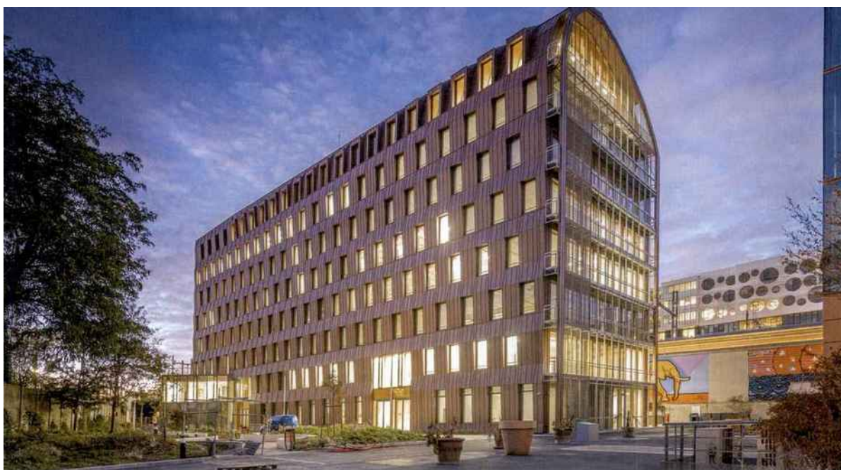
▲ En façade sud, le pignon (est) affiche une haute cimaise traitée en mur-rideau assorti d'une double peau qui, pourvue de balcons et de passerelles de maintenance, est insérée dans une fine ossature d'acier, habillée d'une résille en zinc sinusoïde perforé.
