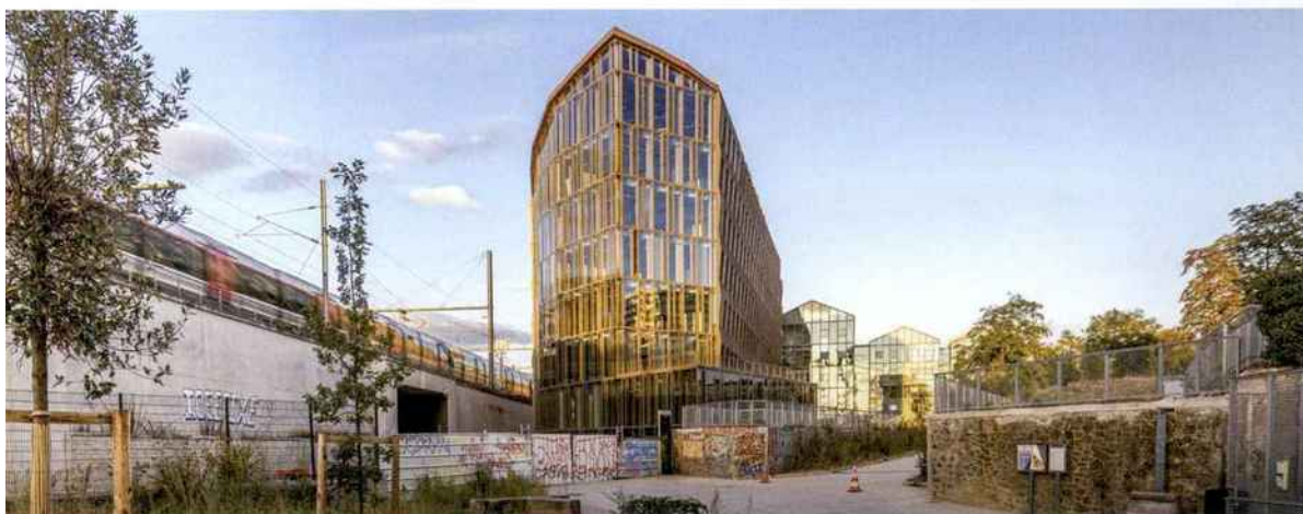
▲ Longeant la voie ferrée, la façade pignon ouest, vitrée, est traitée différemment du pignon est, par un jeu de menuiseries en bois blond qui contraste avec le revêtement rouge global. Le niveau bas, qui vient en avancée, est vitré de la même manière, en continuité.
