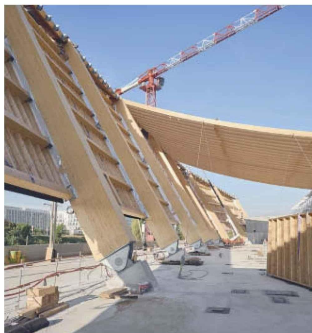
Chaque pièce métallique de liaison entre les poteaux béton et bois a été posée avec une précision millimétrique.
