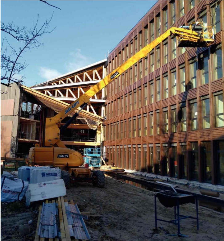
↑ Finalisation de la façade.
