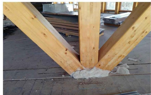
↑ Flocage des fixations en acier.
