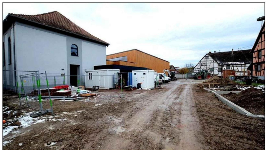
Le cœur du village se transforme avec à gauche, l'ancienne synagogue, la salle du conseil municipal et le gymnase, à droite au sol, les fondations de la halle du marché couvert.
