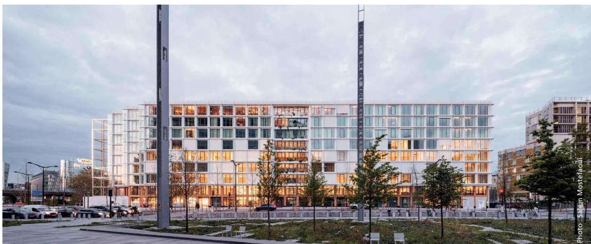
▲ Instrument de la ville de demain, le Stream Building joue une nouvelle partition dans un quartier en devenir. Entre un parc de 10 hectares et l'audacieux tribunal de grande instance de Paris.
