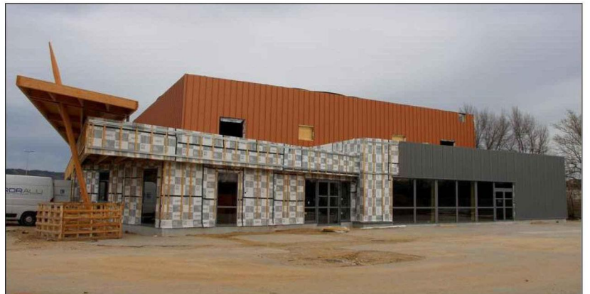
Le bâtiment en construction, déjà bien imposant.
