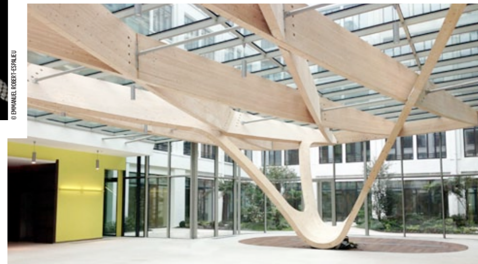
HALL D'ACCUEIL DU CENTRE D'AFFAIRES IN/OUT DE BOULOGNE-BILLAN COURT. ARCHITECTE : DTACC / ARCHITECTE INTÉRIEUR : AGENCE JOUIN MANKU.
