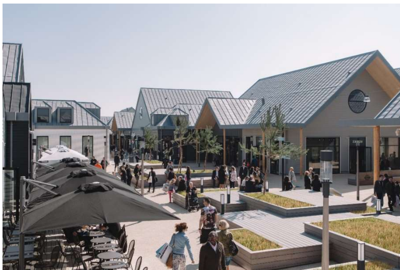
Complexe commercial Marques Avenue A13 à Aubergenville (78) - ©Eric Mercier
