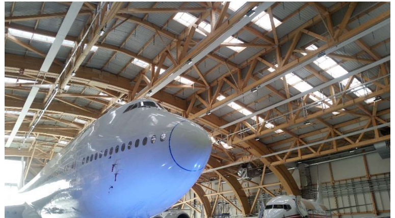
Hangar pour Boeing 747 de l'aéroport international de Bâle/Mulhouse
