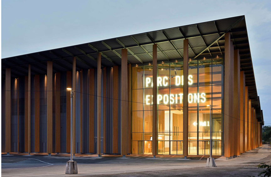
MOA : Eurométropole de Strasbourg - Architecte : Kengo Kuma Associates ©Christophe Bourgeois
