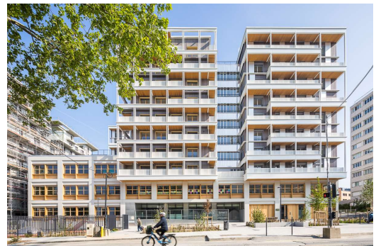
104 logements à Issy les Moulineaux (92)
