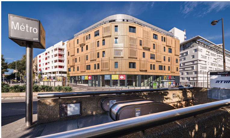
Immeuble de bureaux Nexity à Marseille (13) - ©Yann Bouvier
