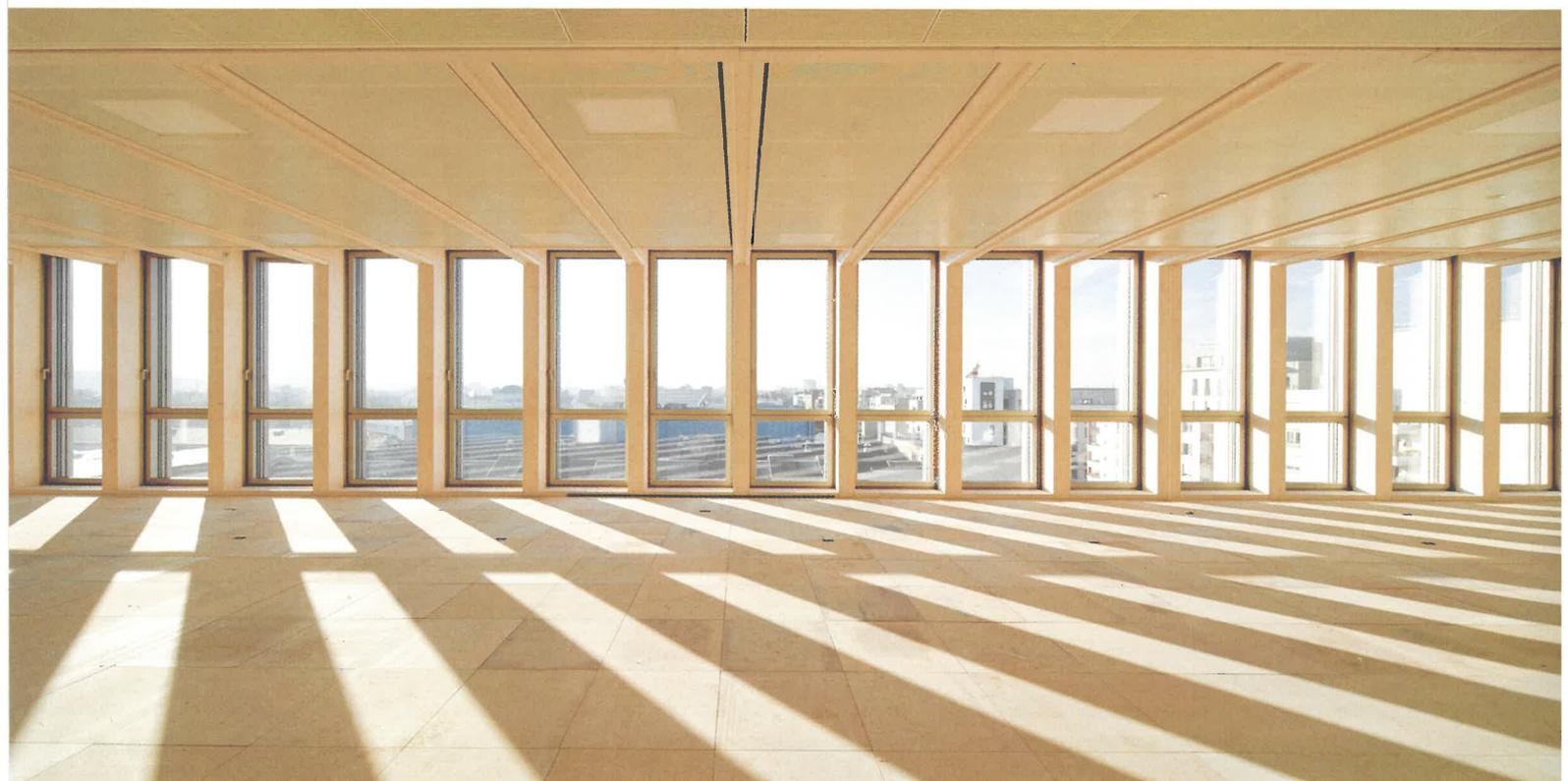
**Imaginé par Fassio-Viaud (alias BFV architectes), le nouveau bâtiment de bureaux d'Icade dans la ZAC Nozal - Front populaire, à Saint-Denis, montre qu'il est désormais possible de construire avec une structure mixte bois-béton, sans surcoût par rapport au 100 % béton. Son vaste atrium et la prééminence de la trame constructive dans la constitution des espaces rappellent les anciens entrepôts de la Plaine Saint-Denis.**
