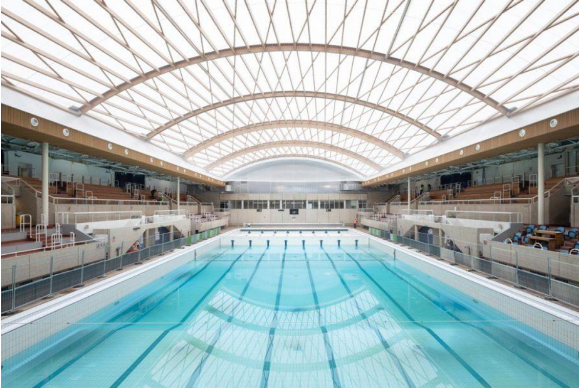
Piscine Georges Vallerey, AIA Life Designers & Romain Viault, toiture fermée © Hugo Hébrard
